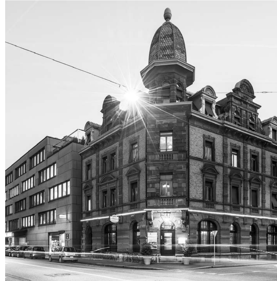
Gemischt genutztes Gebäude, Grenzacherstrasse 60, Burgweg 3, Basel
